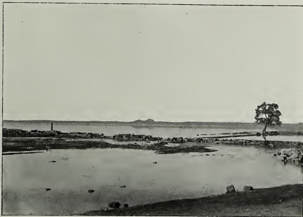
Fig. 59. — Plaine de Mo'azzam transformée en lac. Au centre, les débris du barrage.
